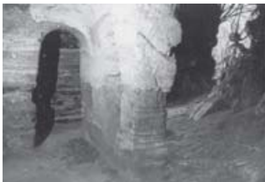
Abb. 3: Vorraum der mittelalterlichen Westlichen Kapelle in Tihany.
