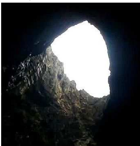
Fig. 5. The shaft originated due the collapse opens to the ground surface Abb. 5: Dieser durch einen Einbruch entstandene Schacht öffnet sich an der Oberfläche
