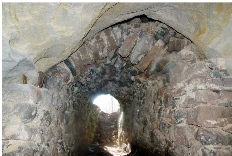
Walls and coves of the cave in the Posolotino village, fixed by the granite masonry Wände und Buchten der Höhle im Dorf Posolotino, gesichert durch das Granit-Mauerwerk
